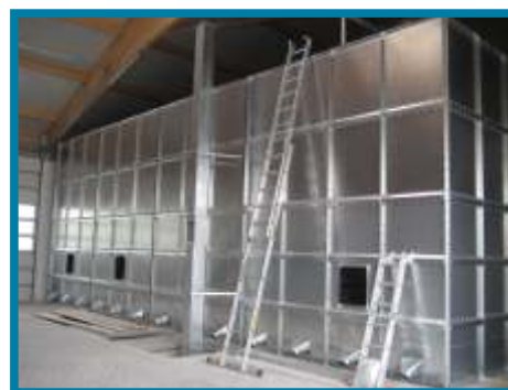
Rechtecksilo mit Fließboden
