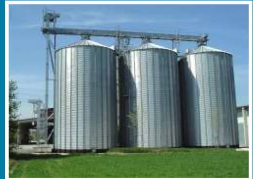
3 Getreidesilos mit Becherelevator und Traggelenkförderer
