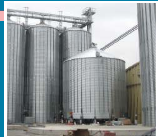
Silomontage mit Hebewinden
