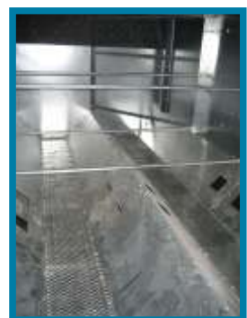
Fließboden in Rechtecksilo
